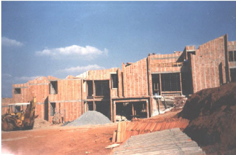
Figura 214: Fotos da construção do conjunto com sistema construtivo utilizado a base de painéis de tijolos ou telhas cerâmicas. Fonte: www.prg.unicamp.br/moradia/16Anos-historia.html
